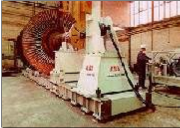
Mit einer mobilen Dreheinrichtung können Turbinenläufer und Generatorrotoren kostensparend direkt beim Kunden repariert werden.
